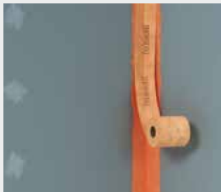
Fig. 19a : Poser la Bande d'étanchéité fermacell sur la couche encore humide appliquée précédemment de l'Étanchéité fermacell .
