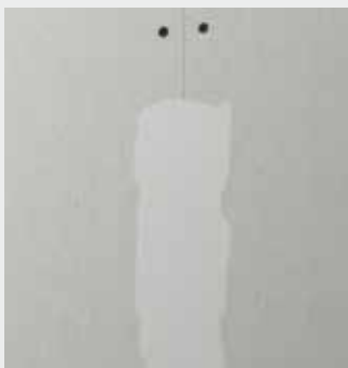
Joint collé et enduit
