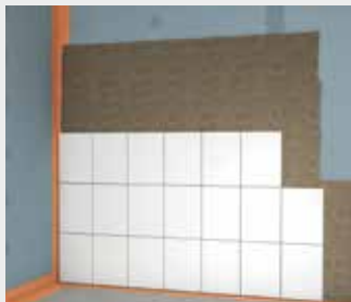
Fig. 22 : Utilisation de Plaques fermacell Powerpanel H 2 O en intérieur. Les carreaux sont posés sur une fine couche de Mortier-colle flexible fermacell (protégeant contre une taux d'humidité de classe A01).
